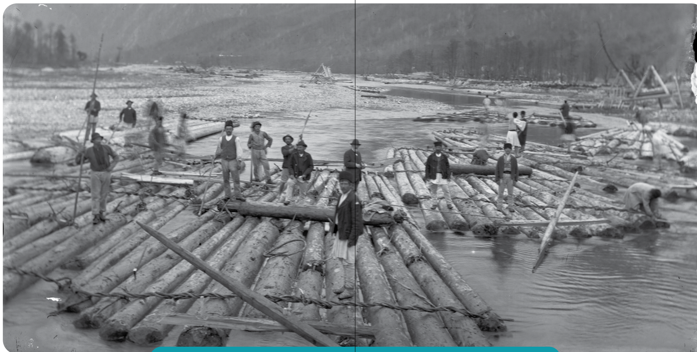
Construção de jangadas de toras (sul da Romênia; ca. 1900)
