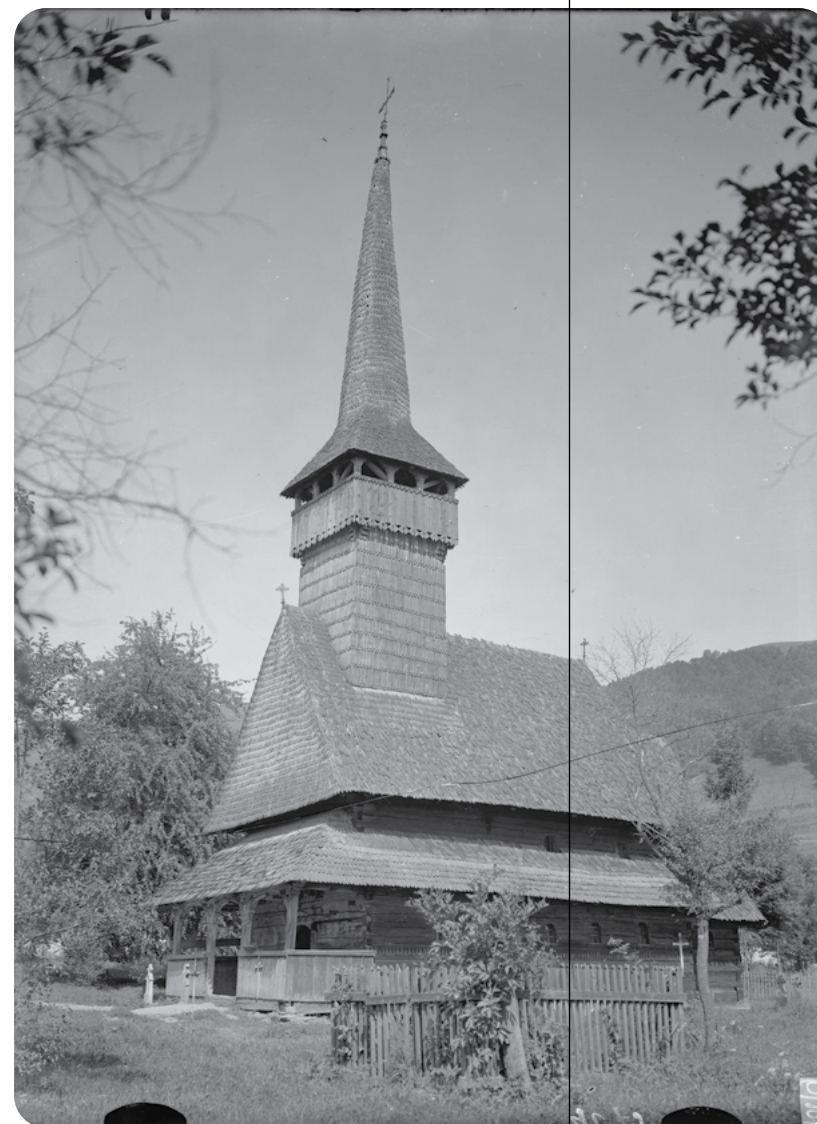
A igrexa de madeira de Rozavlea (Rumania, condado de Maramureș – aprox. 1920-1950)
